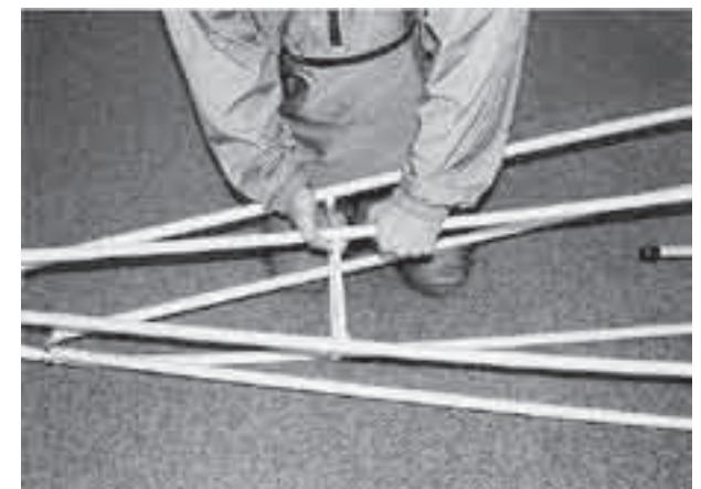
Kパイプ先端の可動パート(TB-F)にDFパイプのピンの無い方を差し込み、リブ3上部の穴にDFパイプの先端ピンを奥まで差し込みます。次に、DFパイプの途中の、パイプが二重になっている部分がリブ2とリブ3の間になるように、DFパイプを取り付けます。
