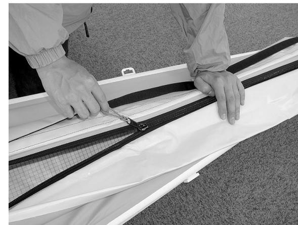
コーミングベルトがGパイプの上になっている事を確認し左右均等に締めます。(断面図参照) リアデッキのファスナーバックアップベルトを締めてからファスナーを閉じます。
